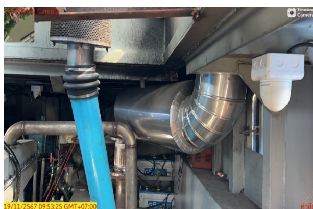
รูปที่ 2.2-24 เรือนต์ลากจูงที่ติดตั้งตัวเก็บเสียง (Silencer)
