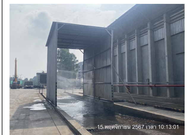
รูปที่ 2.2-4 เครื่องฉีดน้ำแรงดันสูงแบบอัตโนมัติบริเวณบ่อล้างล้อ เพื่อล้างล้อรถบรรทุกก่อนออกจากพื้นที่โครงการ
